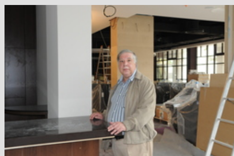
ISA-GUIDE Chefredakteur Reinhold Schmitt besichtigt die Baustelle
