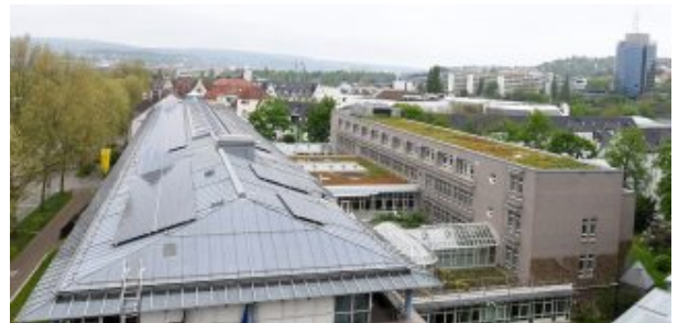
Photovoltaikanlage auf dem Dach der Lotto-Zentrale. (Foto: Lotto Baden-Württemberg)
